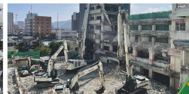
▲東棟解体の様子
