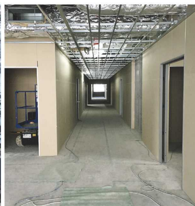
▲4階フロアの内装工事の様子
