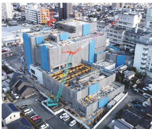
▲北西方向から見た全景
